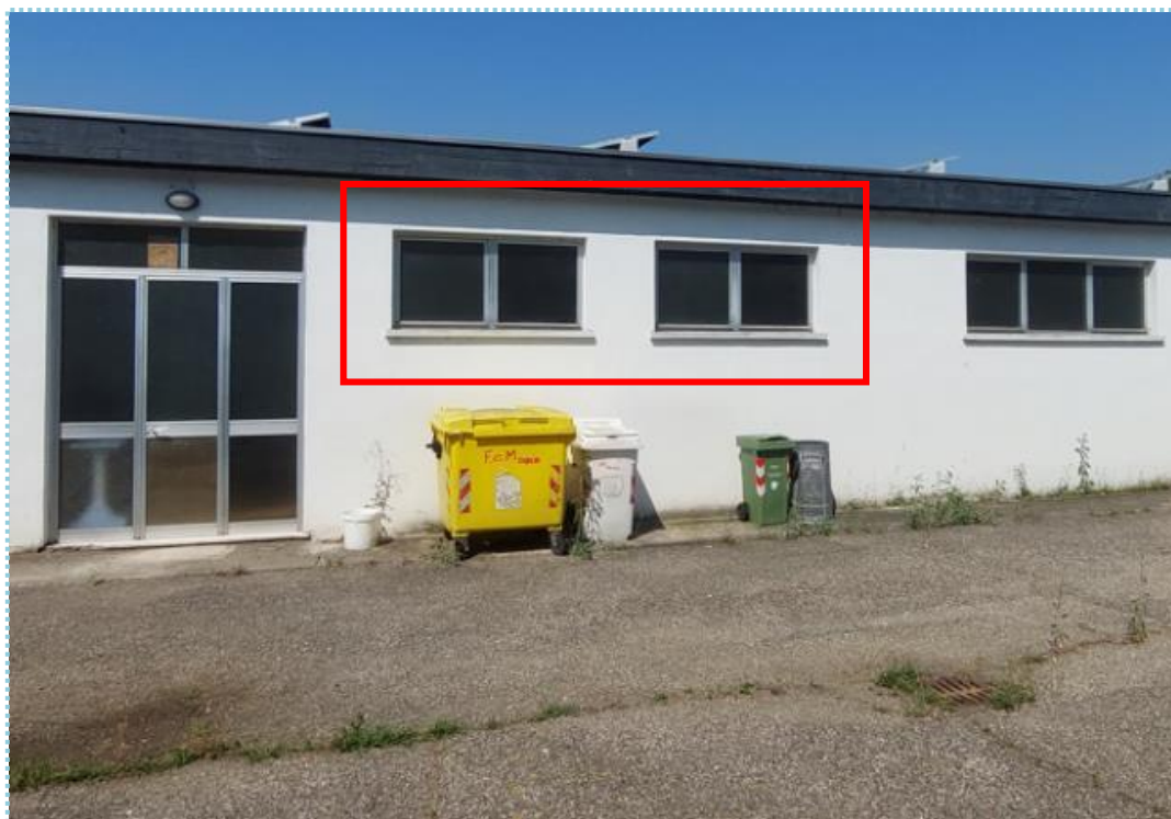
Figura 31 – Immagine finestra 2 ante ferro vetro singolo
