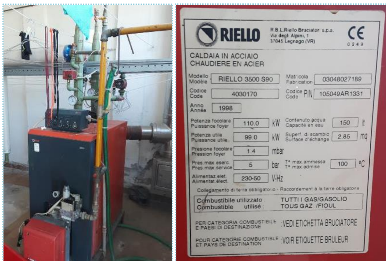
Figura 55 – Dettaglio della caldaia Riello
