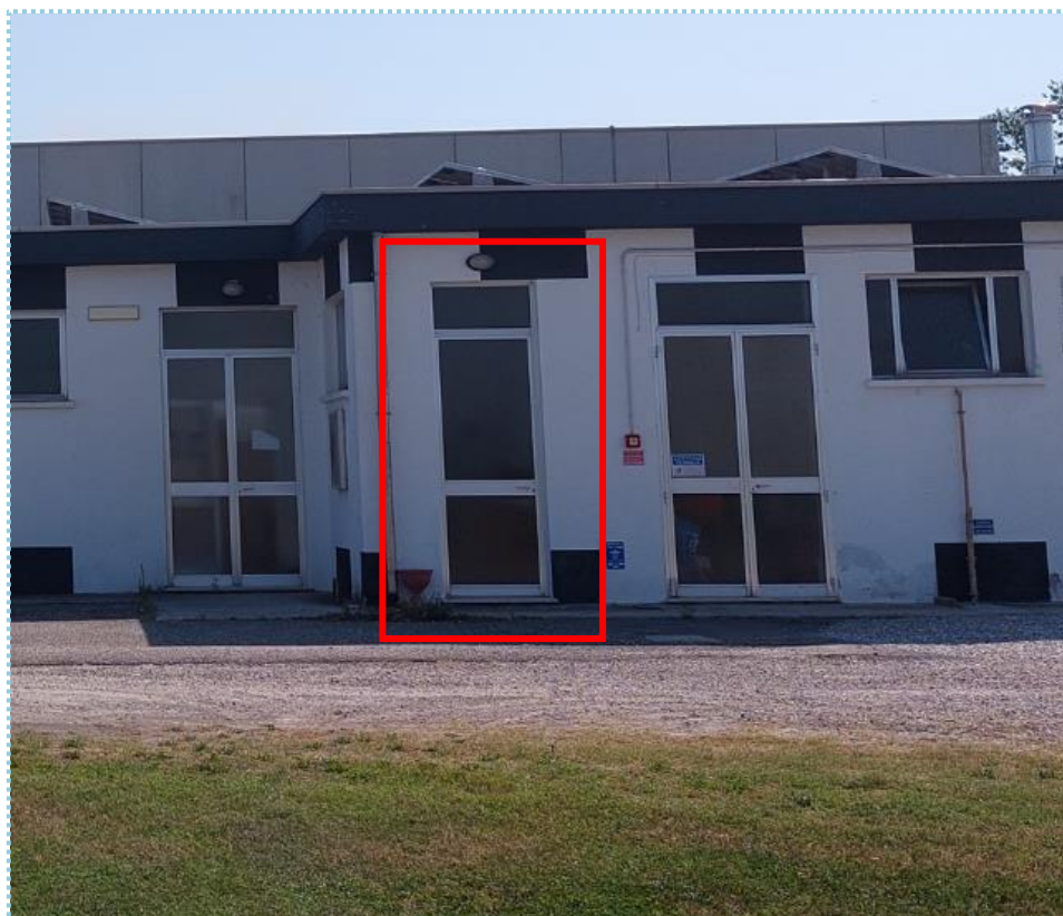
Figura 37 – Immagine portafinestra 1 anta ferro vetro singolo
