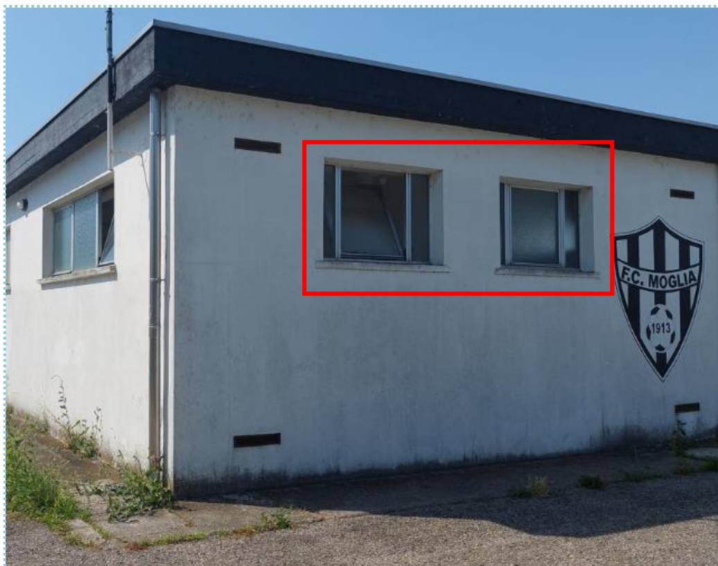
Figura 28 – Immagine finestra 1 anta + 2 ante fisse ferro vetro singolo
